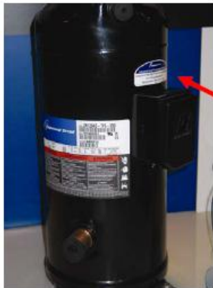
Рис 14: Прогрессивная тепловая защита спирального компрессора (ASTP)
